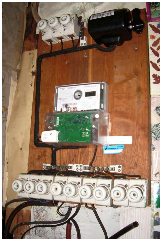
Figur 4: Huvudcentral med elmätare.
